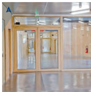
A : Bloc-porte 2V GV DA LINTEAU 2 vantaux vitrés égaux avec imposte et cloison vitrée adjacente
