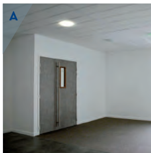
A : Bloc-porte 2V UNIPHONE (sans point de fermeture) 2 vantaux inégaux, finition stratifiés ELAN, avec bâton de maréchal et regard vitré
