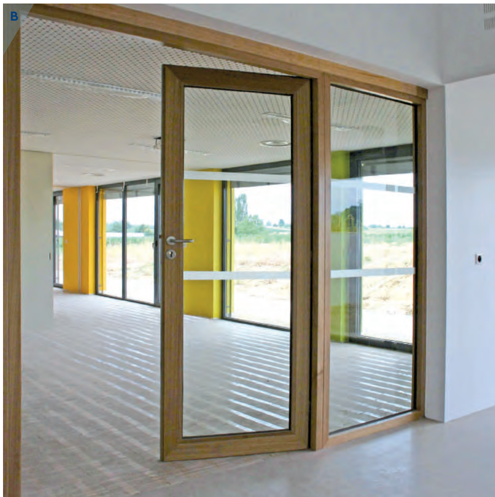
A : Bloc-porte 2V EW30 - VITRE 2 vantaux vitrés inégaux avec imposte et châssis vitrés adjacents B : Bloc-porte 2V EI30 – VITRE 2 vantaux vitrés égaux avec châssis vitré adjacent C : Bloc-porte 2V EI30 – VITRE 2 vantaux vitrés égaux avec cloison filante adjacente avec traverses intermédiaires
