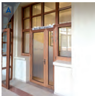
A : Bloc-porte 2V EW30 - VITRE 2 vantaux vitrés inégaux avec imposte et châssis vitrés adjacents B : Bloc-porte 2V EI30 – VITRE 2 vantaux vitrés égaux avec châssis vitré adjacent C : Bloc-porte 2V EI30 – VITRE 2 vantaux vitrés égaux avec cloison filante adjacente avec traverses intermédiaires
